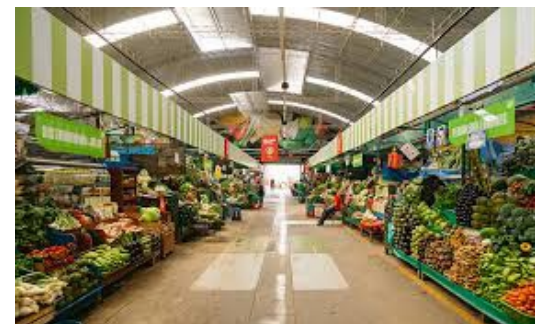
La obras del Mercado Mayorista es el caro anhelo y esperanza de la zona sur, obra que será ejecutada por la M.P.A. Alc. Ing. Víctor Hugo Rivera Chavez.
