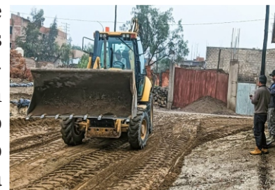
En la vista se aprecia los trabajos de nivelación de vías como parte del saneamiento físico legal en Cayma.
